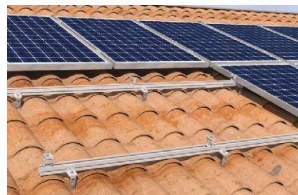
Dettaglio: Posizionamento dei morsetti
